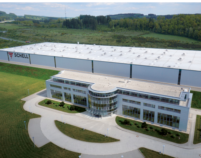
Stabilimento 1 Produzione con sito amministrativo e centro di formazione
